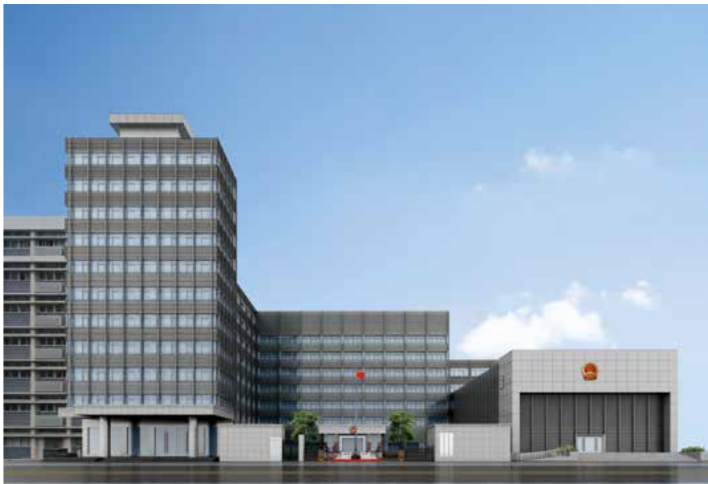
最高人民法院第一巡回法庭 办公楼（深圳） Office building of the SPC First Circuit Court (in Shenzhen)
